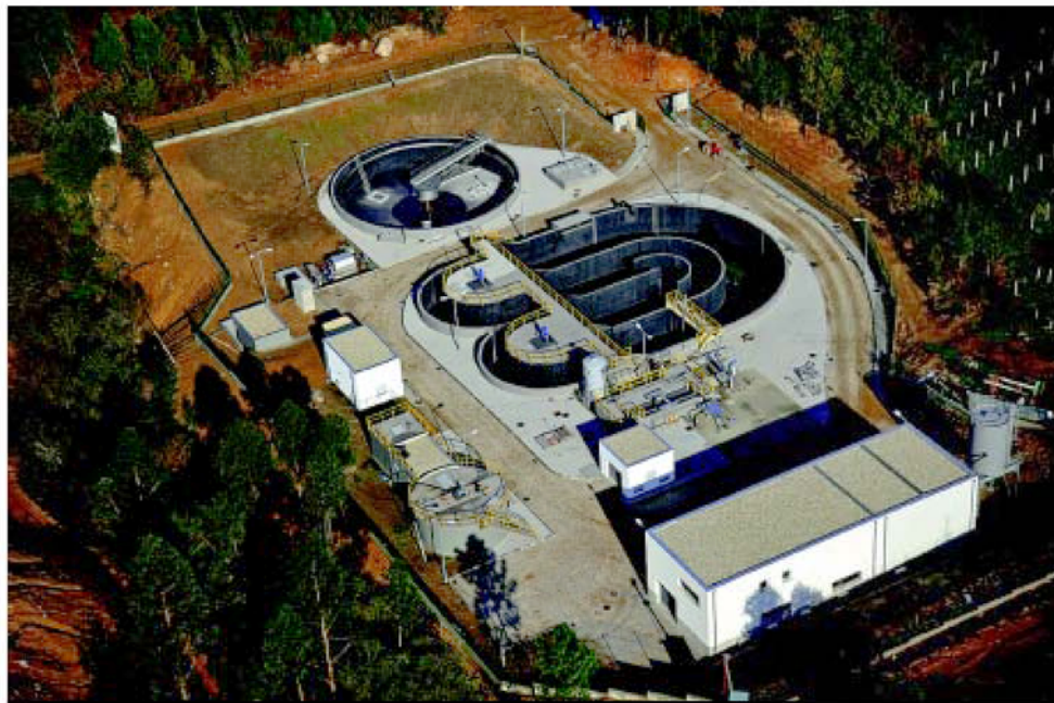
Uma das obras emblemáticas da empresa
